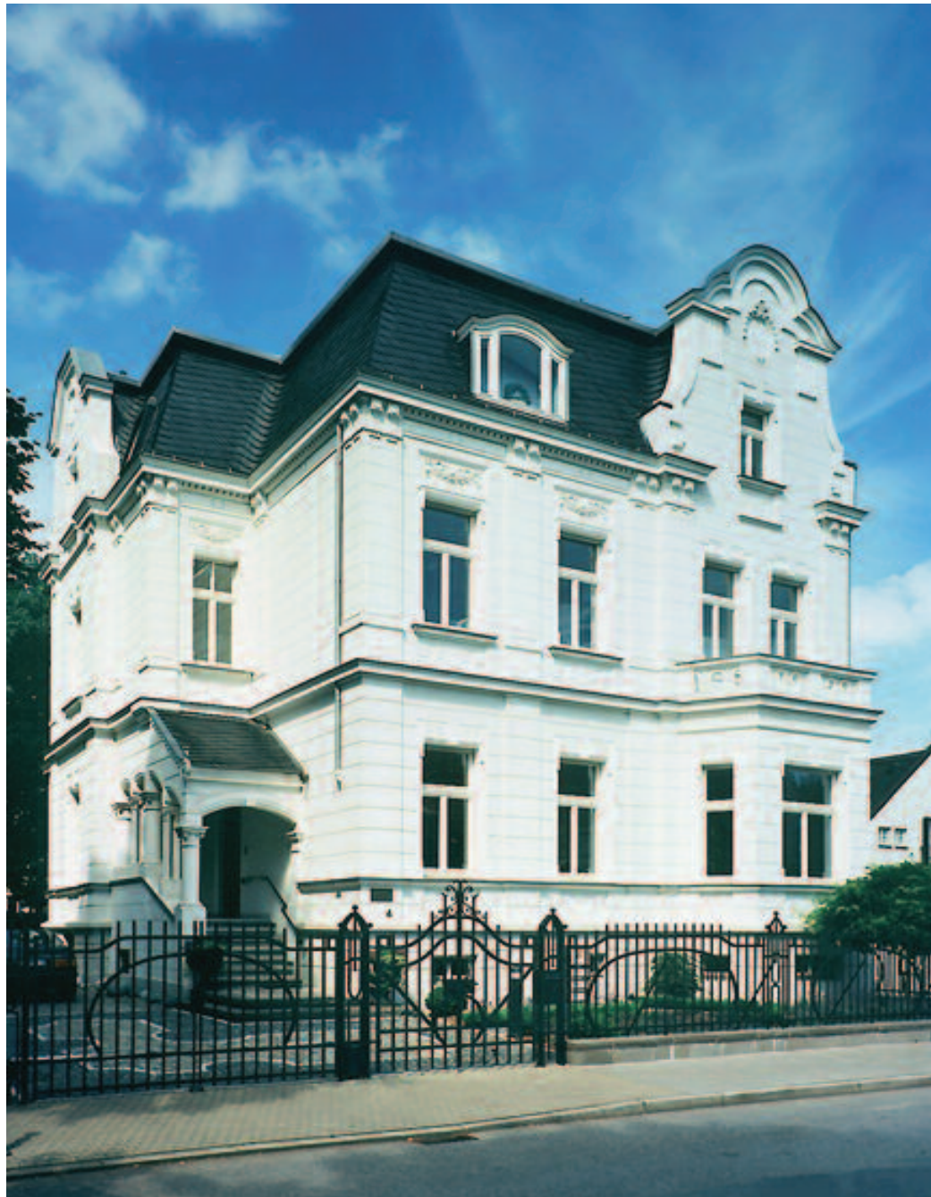
Merantihouten kozijn, volgens richtlijnen Monumentenzorg vervaardigd
