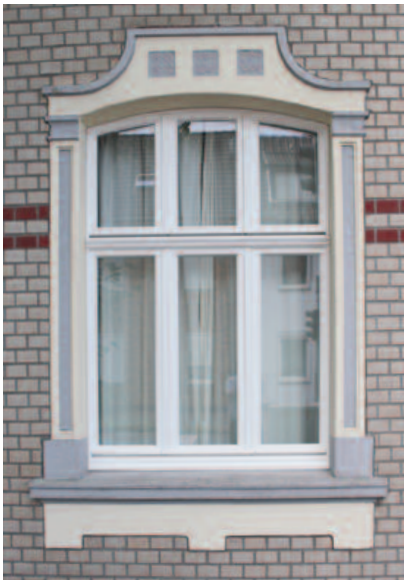
Nostalgische houten kozijnen, het profiel is aan de historische bouwstijl aangepast
