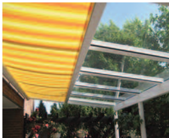
Aluminium-terrasoverkapping, zonwering aan de onderkant, glas 10 mm VSG
