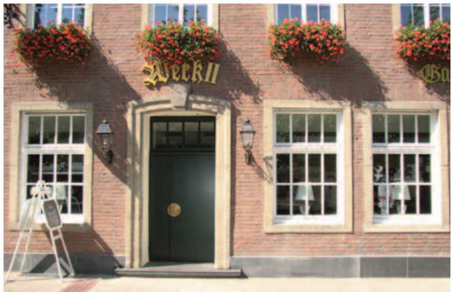
Begane grond: witte houten kozijnen, groen gelakte houten huisdeur, 1 ste verdieping: witte kunststof kozijnen, roedes
