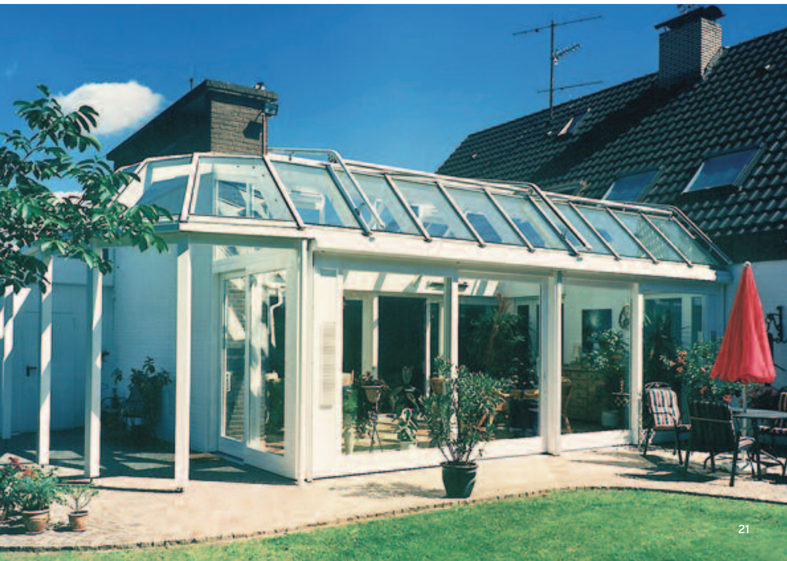
Houten/ aluminium woonserra, solarknik, zonwering, automatische ventilatie, links een apart zitje
